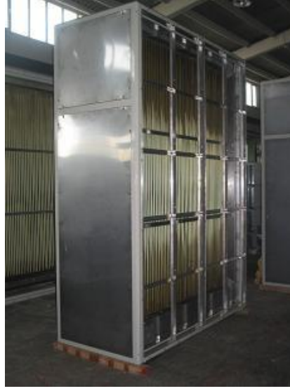
Şekil 13.1-2-3: Soğutucu Ünite Hücresinin Damla Tutucu ve Filtre kısmından görünüşü (Filtre kartuşları tesiste monte edilecek)
