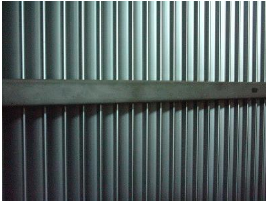
Şekil 14.1: Damla tutucu detayı- sağ ve sol taraftan
