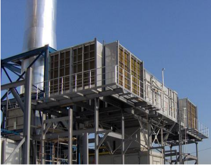
Resim.3- Türbin Giriş Havası Soğutma Ünitesi Uygulama Örneği
